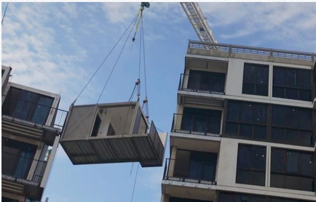
以組裝合成的方法建築，可以加快速度興建更多房屋。
